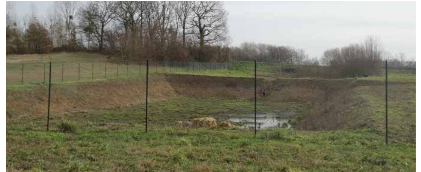
Vue sur le bassin de régulation des eaux pluviales aménagé sur l'emprise communale en face de la mairie.
