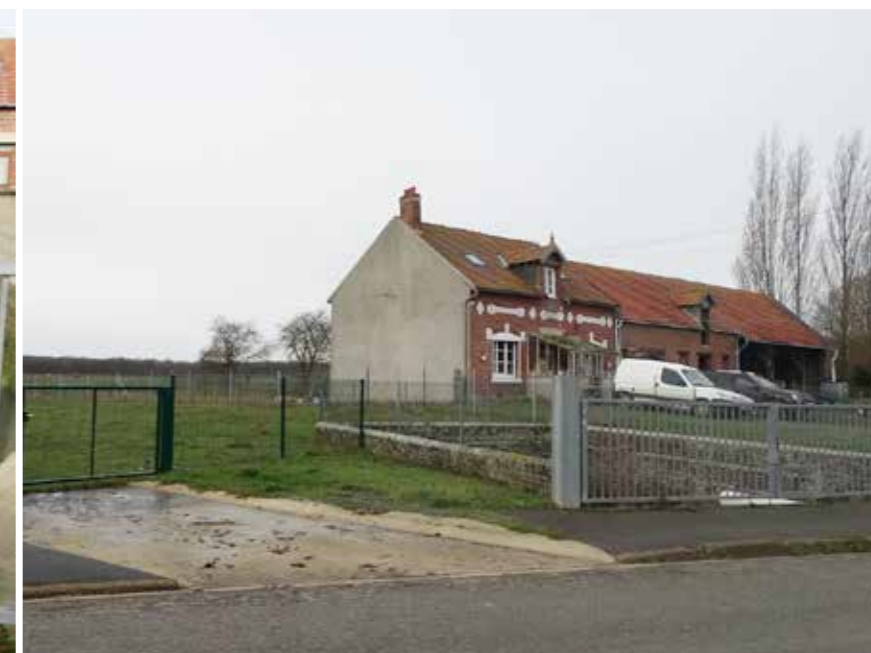
Mare au nord de la rue Principale, aménagée pour réguler les eaux pluviales.
